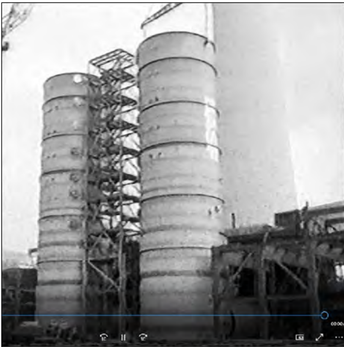
Les deux tours en cours de montage près de la cheminée
