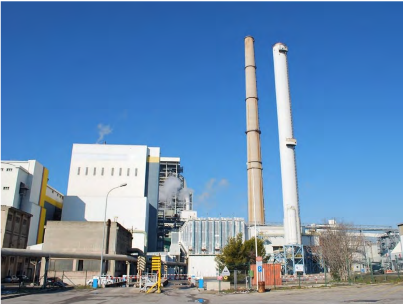
Centrale 600 MW de Gardanne et ses deux réfrigérants atmosphériques. Sa chaudière à charbon se trouve derrière la cheminée blanche. La petite cheminée correspond à l'unité à biomasse de 150 MW dont le bardage de la chaudière est également blanc. Photo. JMT - Janvier 2021.
