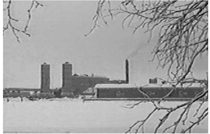
L'installation vue de loin.
